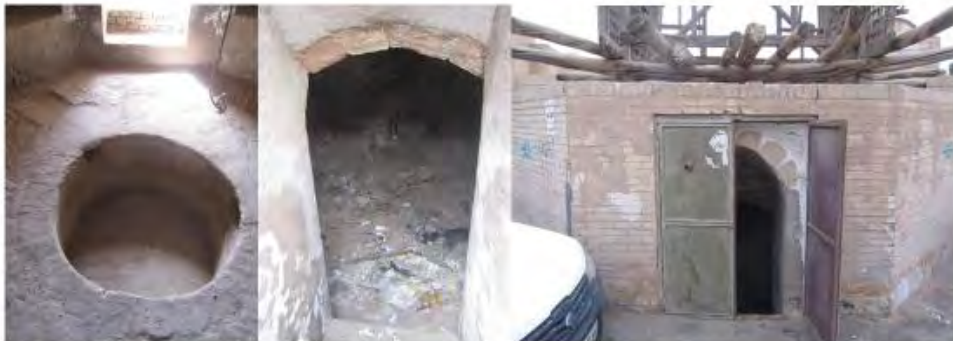
تصویر ۳- سمت راست: نمای بیرونی کلک و ورودی پایاب، وسط: فضای زیر کلک قبل پاکسازی؛ سال ۱۳۹۷، چپ: حوض قنات وقف آباد بعد از آشکارسازی و پاکسازی پایاب؛ مرداد ماه ۱۳۹۸
