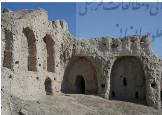
شکل ۲: فرسایش ساختار خشت و گلی کوه خواجه زابل در اثر نفوذ رطوبت ناشی از بارندگی توأم با طوفان شن و وزش باد Fig. 2: Erosion of the clay and mud structure of Koohe Khajeh Zabol due to the penetration of moisture due to rain combined with sandstorms and wind
