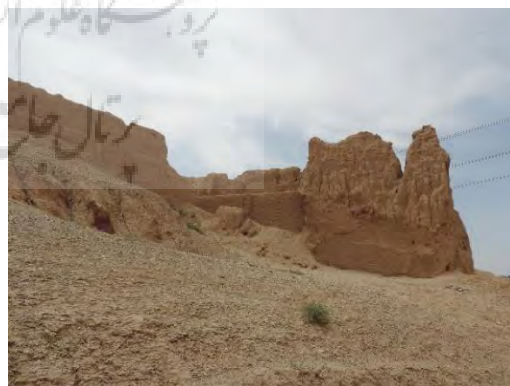
شکل ۱: فرسایش ارگ تاریخی خشت و گلی شهر بلقیس در اسفراین در اثر نفوذ رطوبت ناشی از بارندگی Fig. 1: Erosion of the historic clay and mud Belqis Esfarrayen citadel due to penetration of moisture due to rainfall.
