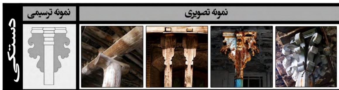
شکل ۱۸. نمونه‌های تصویری سرستون‌های دستکی (از راست به چپ: خانه‌های فتحی، آیینه‌بر و ممتازی و نمونه غیر برداشتی در روستای آسپاس فارس). Fig. 18: Pictorial examples of bracket capitals (Right to Left: Fathi, Ayinehbor and Momtazi House, Aspas Village House)
