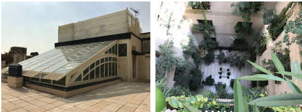
شکل ۲. فضای داخلی و پوشش نورگیر ساختمان بهاران
