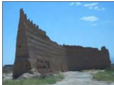
شکل ۲. دیوار سایه‌انداز یخچال نوش‌آباد منبع: نگارندگان
