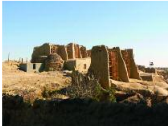
تصویر شماره ۴: منظر آسبادهای ردیف اول از ضلع شمال غربی ساختمان گنبدی متصل به آخرین آسباد
