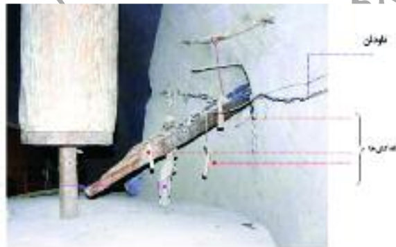
تصویر شماره ۱۱: وضعیت قرارگیری دانه‌کش‌ها، لک لکه و ناودان
