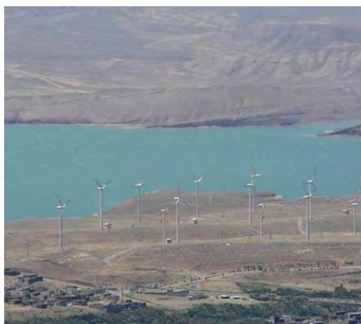
شکل ۶- نمایی دیگر از نیروگاه‌های بادی شهر منجیل
