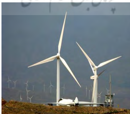
شکل ۵- نمایی از نیروگاههای بادی شهر منجیل
