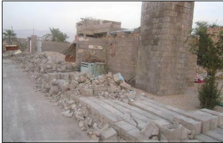
شکل ۱۱- سنگینی دیوارها و ناچیز بودن مقاومت جانبی
