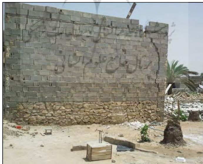
شکل ۱۴- ساختمان‌های بنایی بدون کلاف افقی یا قائم
