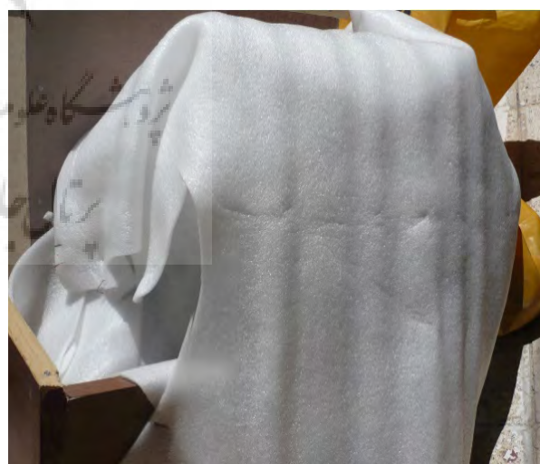
شکل ۱۱. پوشاندن سامانه با فوم برای عایق‌سازی
