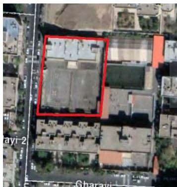
تصویر ۳: جهت گیری ساختمان مدرسه
