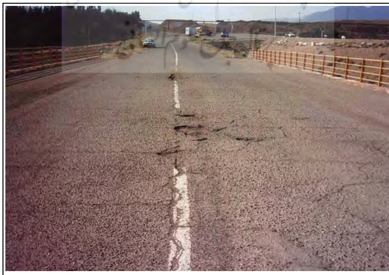
شکل (۱-۸) ترک‌های حاصل از عمل یخبندان آبهای زیر ساخت جاده و تخریب آن
