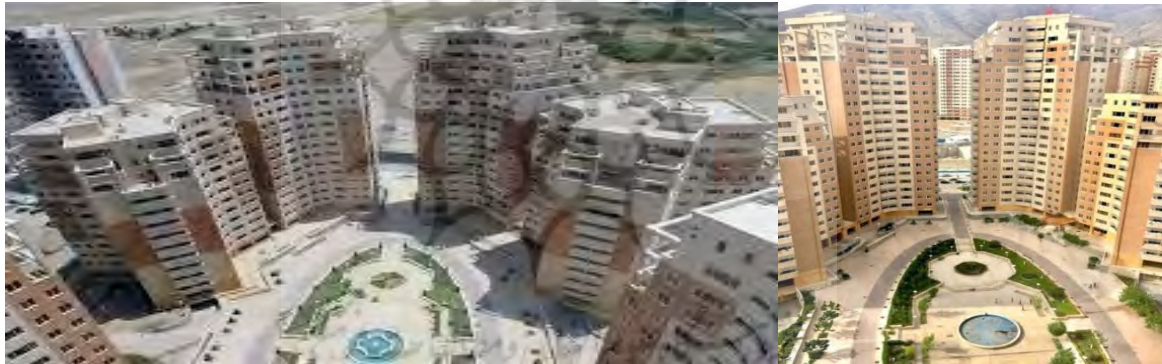
تصویر ۲. محوطه و حجم برج‌های بلندمرتبه مسکونی عرفان در منطقه ۲۲ تهران؛
