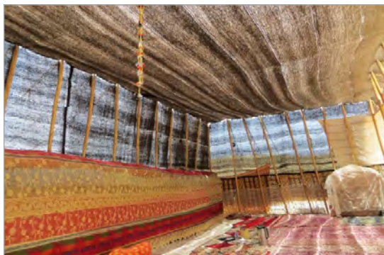
تصویر ۸. باریکه‌های تشکیل‌دهنده سقف و بدنه سیاه‌چادر از جنس موی بز (نگارنده)
