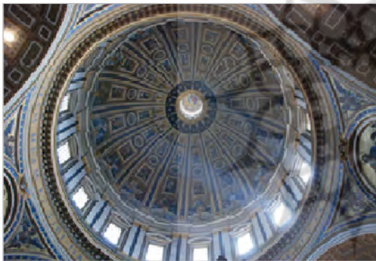
تصویر ۷. دریچه‌های ورود نور از تیزه، بدنه و گریو گنبد اصلی در کلیسای سن پیترو، نمای داخلی (URL: 3)
