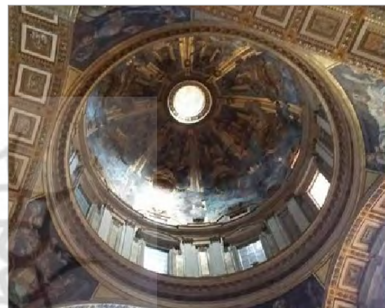
تصویر ۱۲. دریچه‌های ورود نور در گنبد‌های فرعی در کلیسای سن‌پیترو، نمای داخلی (URL: 5)
