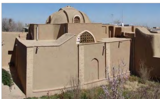
تصویر ۵. نمای بیرونی خانه ملاصدرا در کهنک وضع موجود (نگارندگان)
