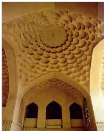
تصویر ۱۰. جزئیات تزئینات سقف گنبدی و طاق باریکه خانه داوید (آرشیو سازمان میراث فرهنگی، ۱۳۸۵)
