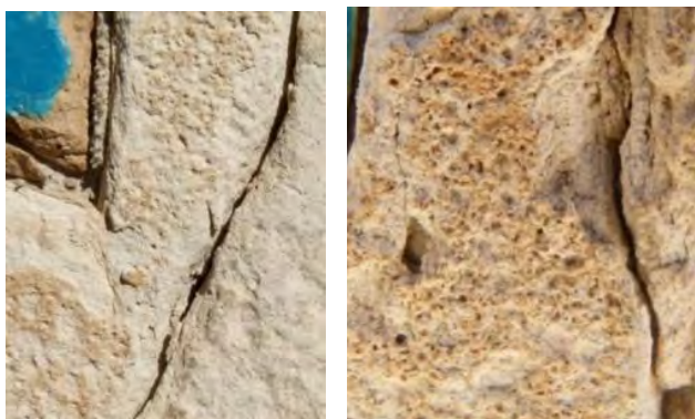
تصویرهای ۲۴-۲۳. وجود ترک در سنگ کتیبه (نگارندگان).
