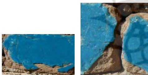
تصویرهای ۱۱-۱۰. پدیدگی و شگستگی لبه کاشی (نگارندگان).
