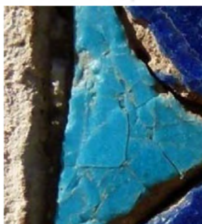
تصویر ۹. وجود ترک و ریزترک در سطح کاشی بر اثر بی‌توجهی هنگام استفاده و ضربه وارد کردن بر آن (نگارندگان).
