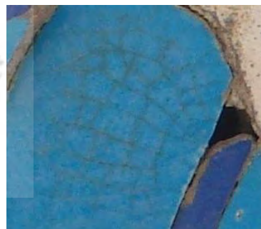
تصویر ۶. نفوذ رطوبت از طریق درزهای بین کاشی و ایجاد ترک در سطح لعاب بر اثر تنش بین لعاب و بدنه (نگارندگان).
