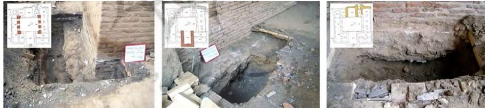
تصویر ۲۰: پی‌سازی بنا در ایوان شمالی (راست)، ایوان جنوبی (وسط) و طاقگان غربی و شرقی (چپ) نشان‌دهنده فقدان پاشنه پی در ایوان شمالی برخلاف دو بخش اصیل دیگر بناست. این پاشنه در ایوان جنوبی و طاقگان، ۳۰ سانتی‌متر بیرون‌زدگی و حدود ۵۰ سانتی‌متر ارتفاع دارد (عمارت خورشید ۱۳۹۰).
