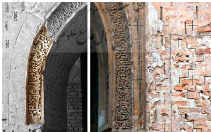
تصویر ۲۹: تزئینات دوره دوم شامل گچ‌بری‌های تزئینی است و بر روی گل‌اندازه‌های آجری و در زیر لایه آجرکاری قالبی ایلخانی قرار دارند.
