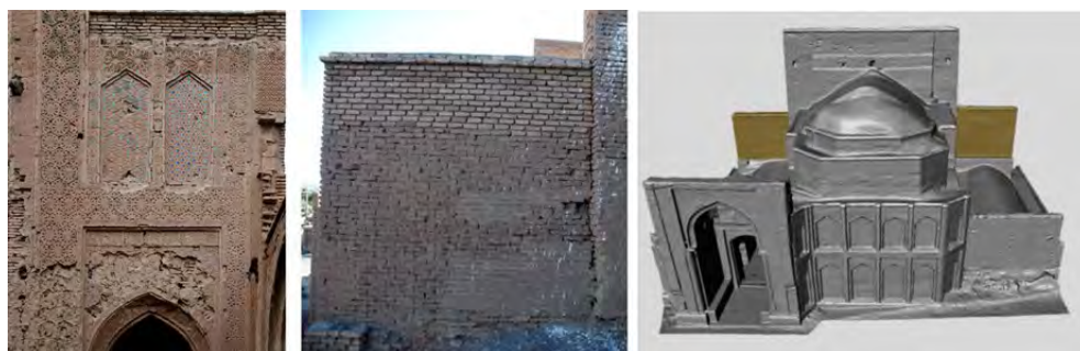
تصویر ۳۵: قاب‌نمای دوتایی غربی ایوان شمالی که به‌رغم گسستگی در ساختار سازه‌ای در هماهنگی با سایر بخش‌های نما، با گره‌سازی درهم تزیین شده است (عمارت خورشید ۱۳۹۰).
