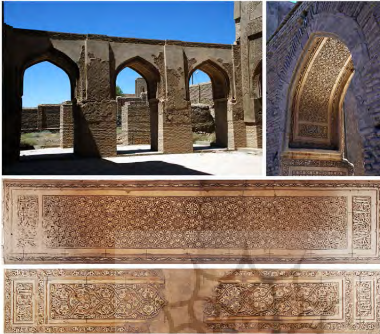
تصویر ۱۶: بالا: طاق‌نماهای سه‌تایی جداره شرقی؛ پایین: تصویر تخت دو نمونه از تزیینات گچ‌بری زیر طاق‌ها (عمارت خورشید ۱۳۹۰)
