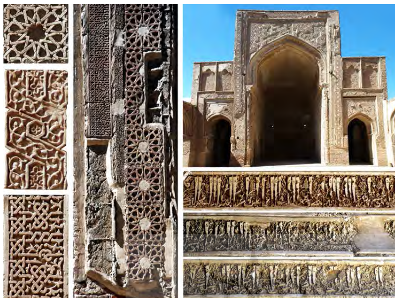
تصویر ۱۲: تزیینات پرتکلف آجرکاری قالبی (نما) و گچ‌بری‌های گلوبی طاق ایوان جنوبی که با کتیبه‌های خط ریحان تزیین شده است.
