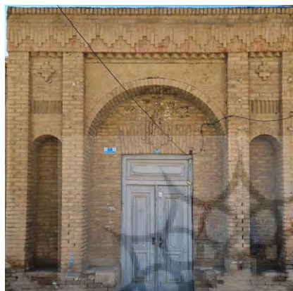
تصویر ۱۲: تزیینات آجرکاری سردر خانه قائمی‌ها
