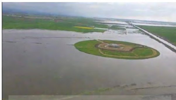
شکل ۸- تصویر هوایی از قسمت انتهایی باند فرودگاه (ماخذ گزارش مقدماتی سیلاب ۱۳۹۸)
