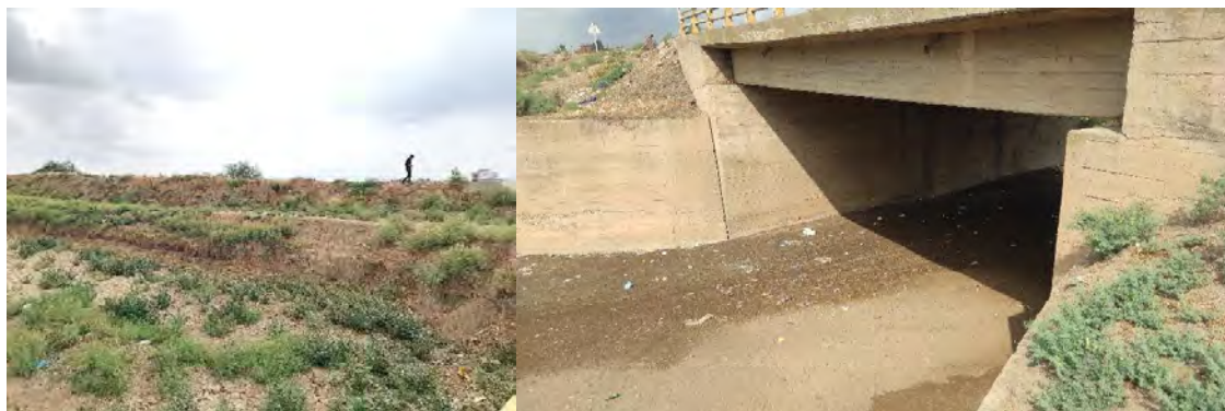
شکل ۱۳- کوچک بودن و کم عمق بودن پل‌های احداث شده بر روی رود (تصویر سمت راست پل ابتدای روستای شور حیات- تصویر سمت چپ پل انتهای روستای قانقرمه)
