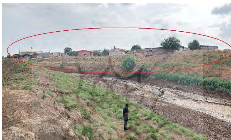
شکل ۱۴- تجاوز به حریم رودخانه با ساخت و ساز غیر مجاز و دیواره‌های ایجاد شده در حاشیه رودخانه (روستای قانقرمه)
