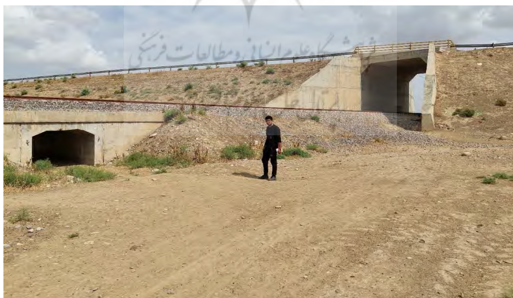
شکل ۷- محل جمع شدن آب در شمال رودخانه و در کنار محل خروجی آب
