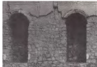
تصویر ۱۹- اتاق با دو طاقچه‌ی گود نشسته و هلال فوقانی واقع در زیر ربع گردی ساختمان آتشکده (فریه، ۱۳۷۴: ۶۳)
