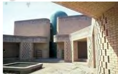
تصویر ۷- نمای از حیاط مسجد (پورجعفر، ۱۳۹۰)
