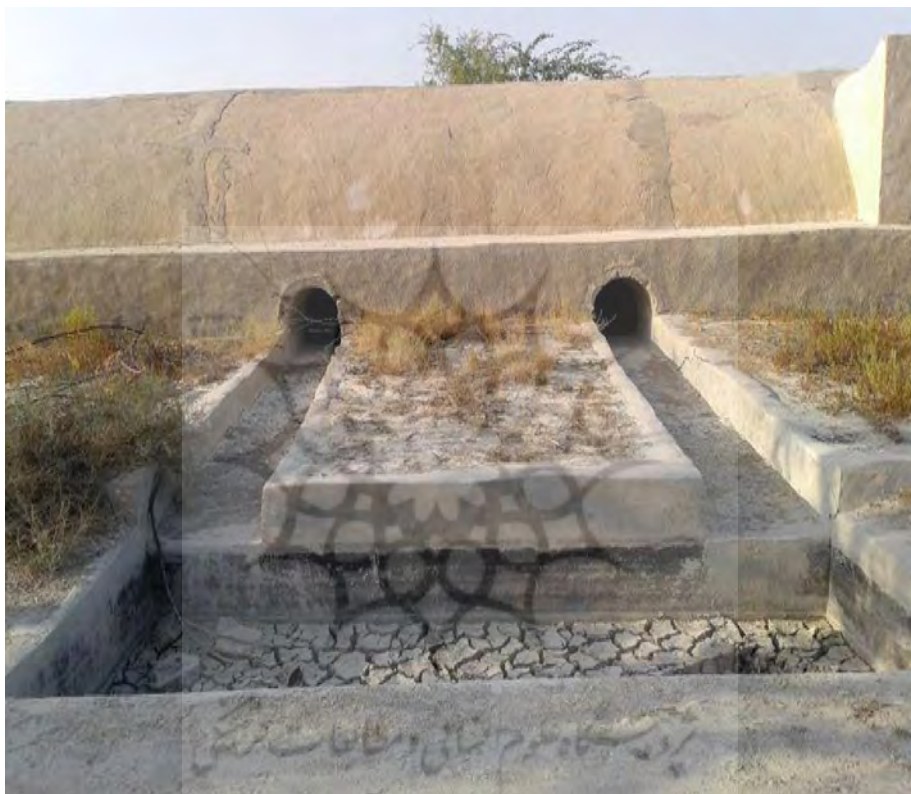
عکس ۷- حوضچه رسوب‌گیر که گل‌ولای ته‌نشین شده پیش از ورود آب به بُرکه در آن مشخص است (میلاذ خواجه مظفری، پی‌پشت، ۱۳۹۵/۶/۱۰)
