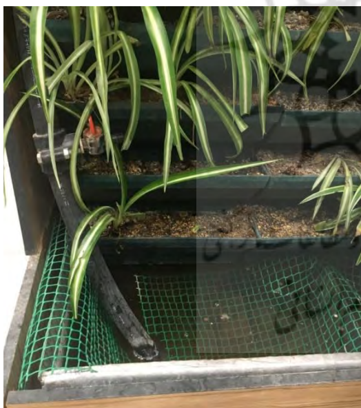
شکل ۵) سیستم آبیاری دیوار سبز باغ کتاب تهران و محفظه نگهداری آب اضافی، منبع: نگارندگان.
