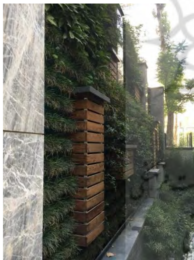
شکل ۲) اجرای دیوار زنده مدولار با جعبه‌های کاشت بر نمای ساختمان در پروژه برج مریم واثق، منبع: نگارندگان.
