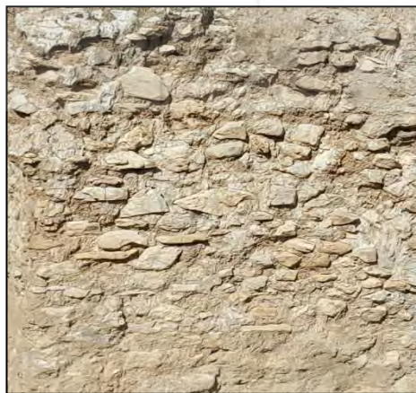
شکل ۱۶. نوع مصالح و ملات بکار رفته در بنای آتشکده کوشک قیفر (نگارندگان)
