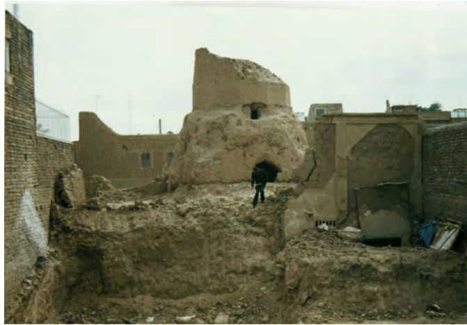
تصویر ۱۴: وضعیت نمای غربی بنای گنبددار در سال ۱۳۸۲ و پیش از ساختن قطعه زمین غربی بنا. در منتهی‌الیه سمت راست تصویر ورودی دخمه قابل مشاهده است. با ساختن این قطعه و تجاوز آن به عرصه باقی‌مانده بنای گنبددار، از وضعیت دخمه و ورودی آن اطلاعی در دست نیست (میراث فرهنگی کاشان ۱۳۸۲).
