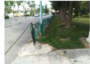
حذف شمشادها و ترون ها در امتداد خیابان انبار گندم و نصب نرده های کوتاه
