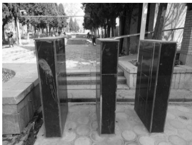
تصویر ۲. عدم دسترس پذیری ورودی. عکس: ندا رفیع‌زاده، ۱۳۹۵.
