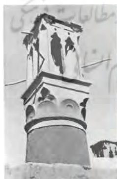
6. — Tour de ventilation de l'ab-ambar sis près de l'imam-zadeh Pendjé.
