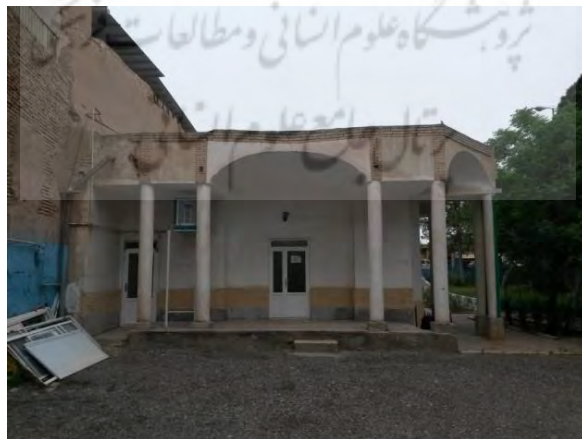
نمای ضلع شرقی بنا (تعظیمی فر)
