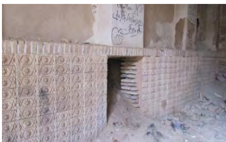
شکل ۲۰: تزیینات آجری و کانال‌های تهویه هوا واقع در دیوار زیرزمین
