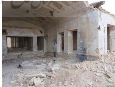
شکل ۶: اتاق‌های ضلع غربی
