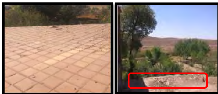
بام حوضخانه پس از مرمت
