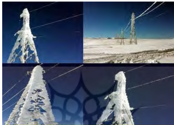
شکل (۱): خسارت برف بر روی دکل‌های انتقال نیرو در منطقه مورد مطالعه
