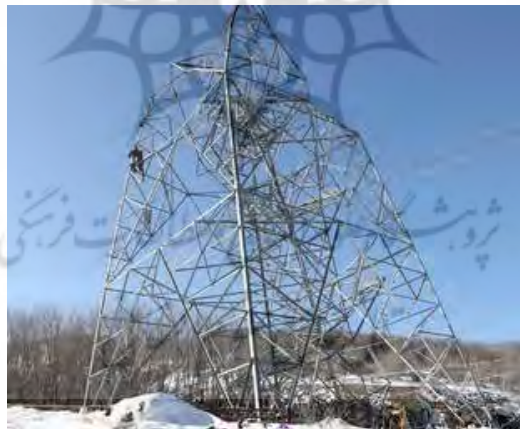
شکل (۲): خسارت برف بر روی دکل‌های انتقال نیرو فشار قوی در منطقه مورد مطالعه
