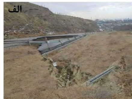
شکل ۴: الف) وقوع زمین‌لغزش در امتداد جاده وادی رحمت به دیزل‌آباد، ب) رانش زمین در محله ۴۲ متری، ج) به دلیل مکان‌یابی نامناسب، ده‌ها واحد مسکونی در آخر خلیل‌آباد در معرض زمین‌لغزش قرار دارند.
