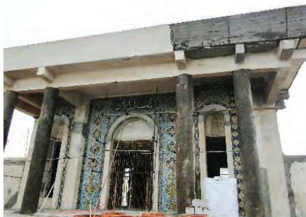
تصویر ۲۲. نمای شمالی بانک ملی در حال مرمت
