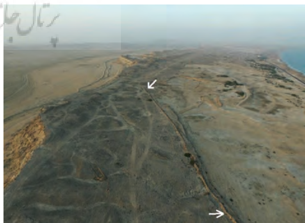
تصویر شماره ۲۶: تصویر هوایی از خاکریز هدایت آب
