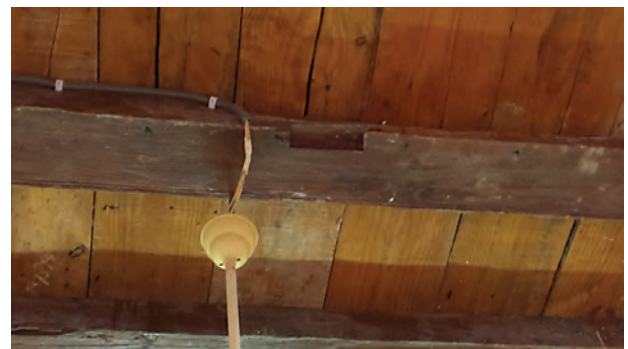
استفادهٔ مجدد از چوب و تخته‌های کشتی در سقف مسجد (عکاس: عبدالجلیل مرداسنگی)
