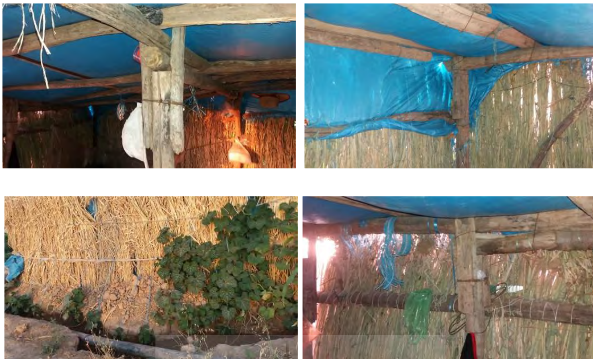
تصاویر ۸ تا ۱۱: نمای داخلی از سازه چوبی و نی‌ها، و نمای خارجی کانال کشی برای رشد گیاه رونده
