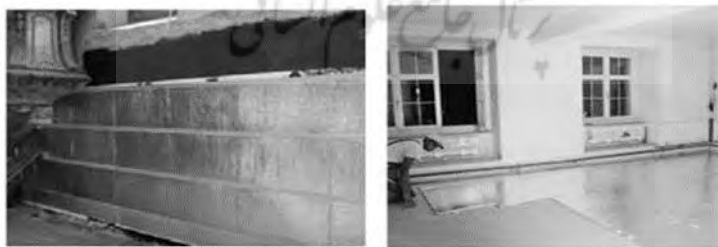
تصویر ۲ - اجرای پنل عایق خلأ در دیوار و کف ( http://www.pnjgroup.ir )
