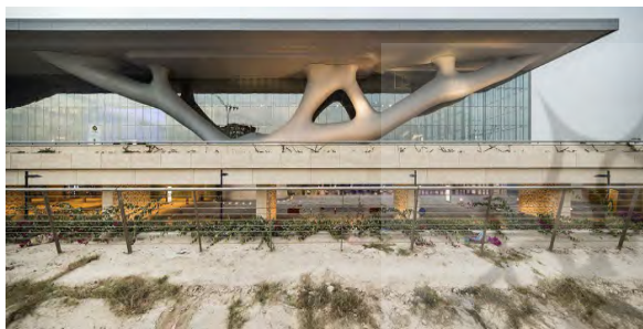
شکل ۳) طراحی پایه‌های سایه‌بان مرکز انجمن‌های بین‌المللی قطر با استفاده از بهینه‌سازی توپولوژی [14]
