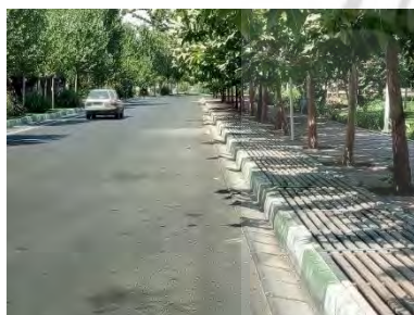
تصویر ۱۲ - کفسازی نامناسب و عدم وجود ارتباط مناسب با ضوابط معلولین در ارتباط با خیابان
