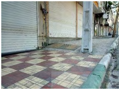
تصویر ۲ - شیب رامپ نامناسب با توجه به اینکه پیاده‌رو خود دارای شیب زیادی است.
