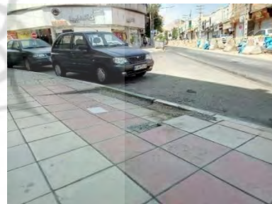
تصویر ۳ - علاوه بر منتهی شدن رامپ به جدول، در تقاطع خیابان از هیچگونه خط‌کشی استفاده نشده است.
