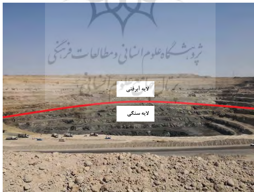
شکل ۴: نمای جانبی از بیت معدن گل گهر و وجود دو لایه آبرفتی و سنگی
