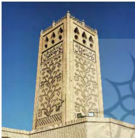
شکل ۸) برج تصفیه کارخانه اقبال یزد [۶]
