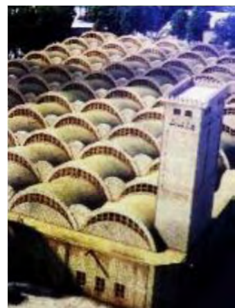
شکل ۵) سالن کارگاهی کارخانه سعادت یزد
