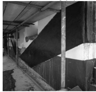
شکل ۲) مقاوم سازی با استفاده از الیاف [23]
