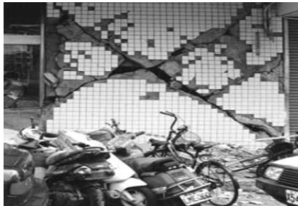
شکل ۳) تشکیل ترک های قطری ایجاد شده در دیوار مصالح بنایی غیر مسلح [23]
