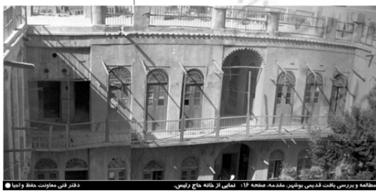
شکل ۱) استفاده از شناشیرهایی که محرمیت ایجاد نمی‌کنند (عمارت حاج‌رییس)
