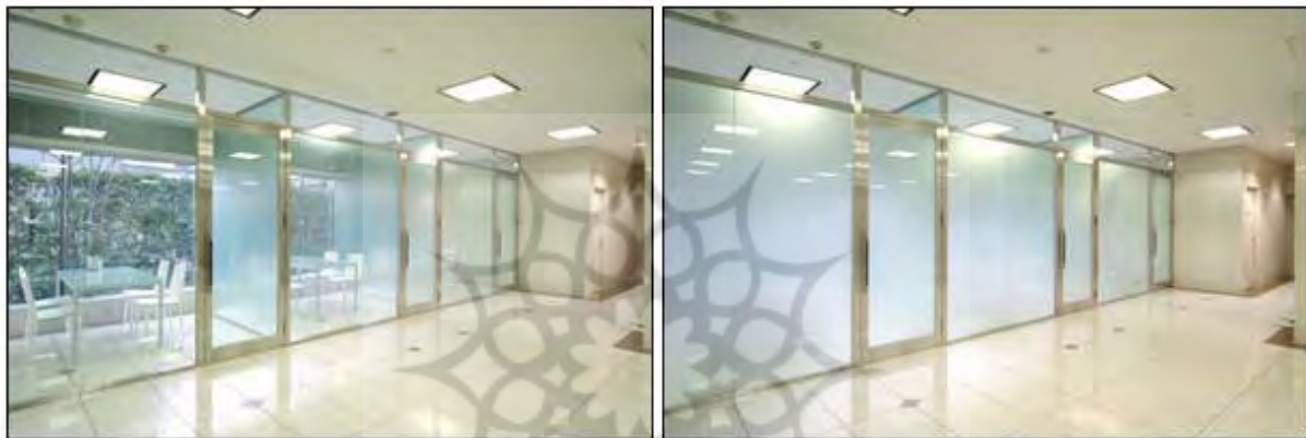
شکل ۲: حالت کدر و شفاف برای شیشه الکتروکرومیک که با زدن یک کلید تغییر می کند. (سرخوش و توکلی دستجردی. ۱۳۹۲).
