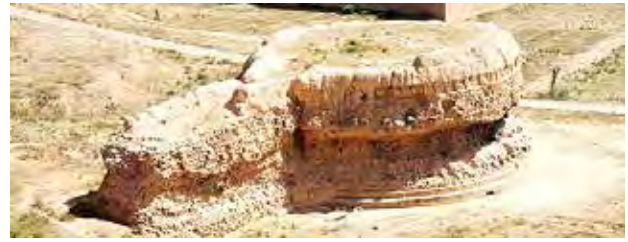
تصویر ۱. نمایی از سازه استوانه‌ای و پل - بازوی برج بزرگ جنوبی در قلعه رشیدیه تبریز. مأخذ: نگارندگان.
