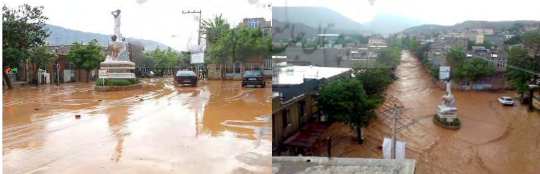
شکل ۱۱: ورود سیلاب به معابر اصلی شهر کلات و خسارت به زیر ساخت شهری منبع (پیریان، اردیبهشت ۱۳۹۱)
