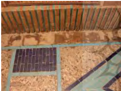
تصویر ۳: بکارگیری کاشی در بندهای آجری در در بند خانه ملک التجار یزد راه فهم فرهنگی از طریق نشانه رامخدوش می‌نماید (ماخذ: نگارندگان)
