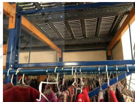
تصاویر ۱ و ۲: میله هایی که به سقف طبقه بالایی وصل شده اند و به عنوان رگال استفاده می شوند (نگارندگان)
